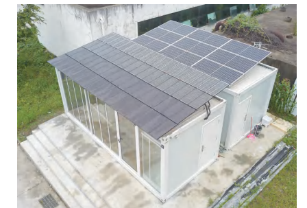
⑥ 安装光伏 Install Solar PV
