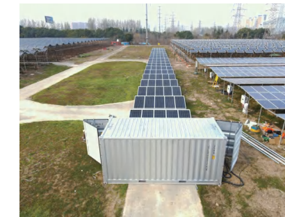
⑤ 电气接线安装 Cable Installation
