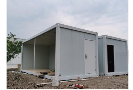
③ 安装墙板 Install Wallboard
