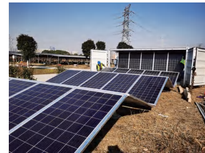
④ 展开光伏阵列 Unfold Solar PV Array
