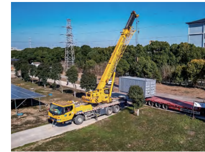
② 吊装就位 Hoisting in Position
