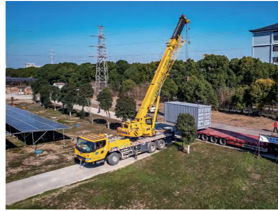
② 吊装就位 Hoisting in Position
