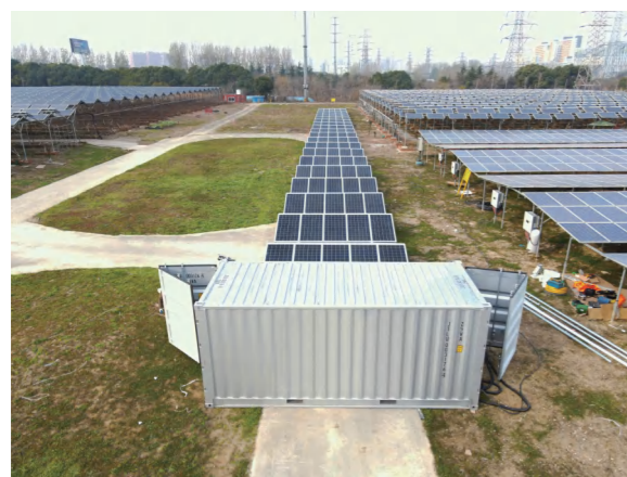
⑤ 电气接线安装 Cable Installation
