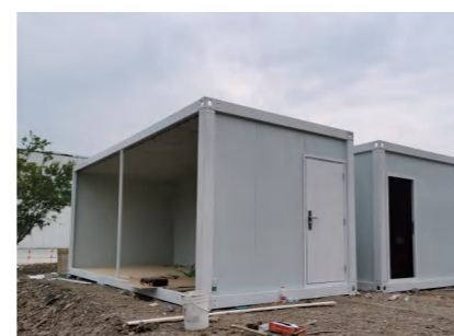
③ 安装墙板 Install Wallboard
