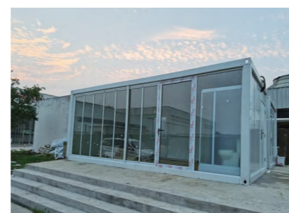
⑥ 施工完成 Final Operation
