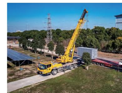
② 吊装就位 Hoisting in Position
