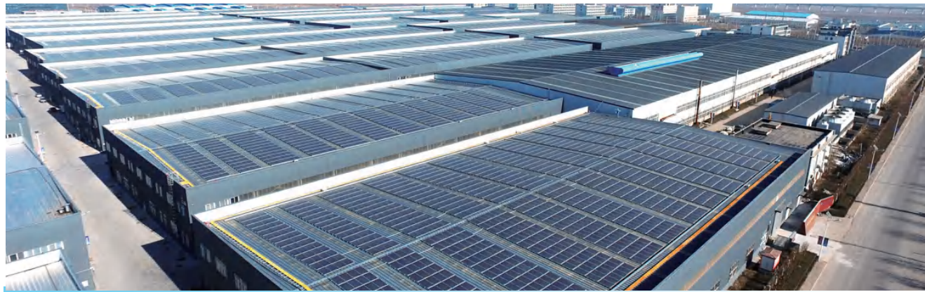
无锡玉祁 祁达纺织4.4MW彩钢瓦顶
