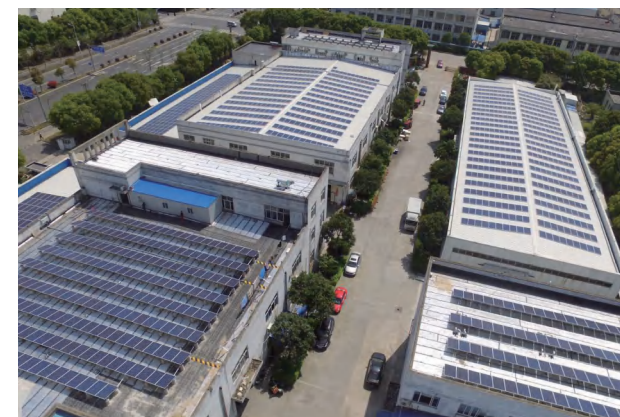
无锡锡山 宝尔森444kW混合屋顶
