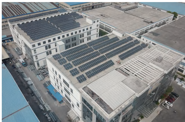
苏州吴中 新泽310kW水泥屋顶
