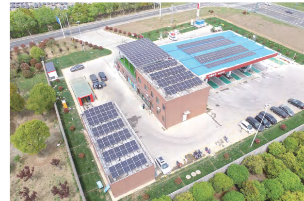
常州武进 中石化125kW加油站
