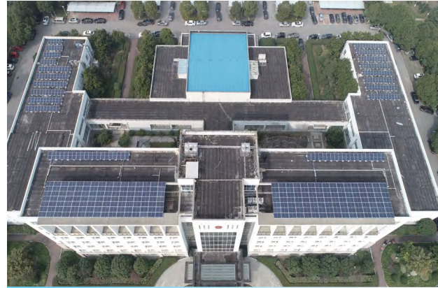
苏州常熟 镇政府大楼200kW水泥屋顶 SUZHOU-200kW
