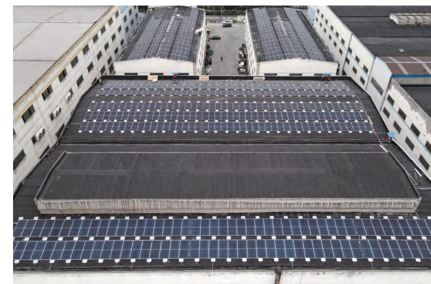
无锡滨湖 捷安轧辊400kW水泥屋顶 WUXI-400kW
